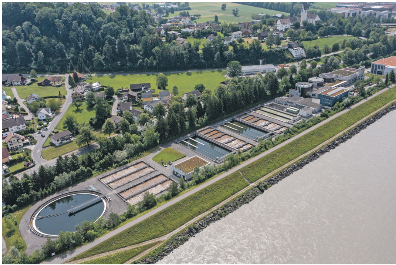
Die ARA Bendern wurde 1976 in Betrieb genommen, fünf Jahre nach der Gründung des Abwasserzweckverbandes. (Fotos: MZ)
